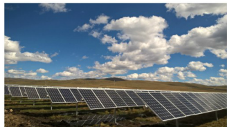
某光伏电站水保险收现场
