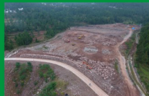
某高速公路渣场变更现场航拍
